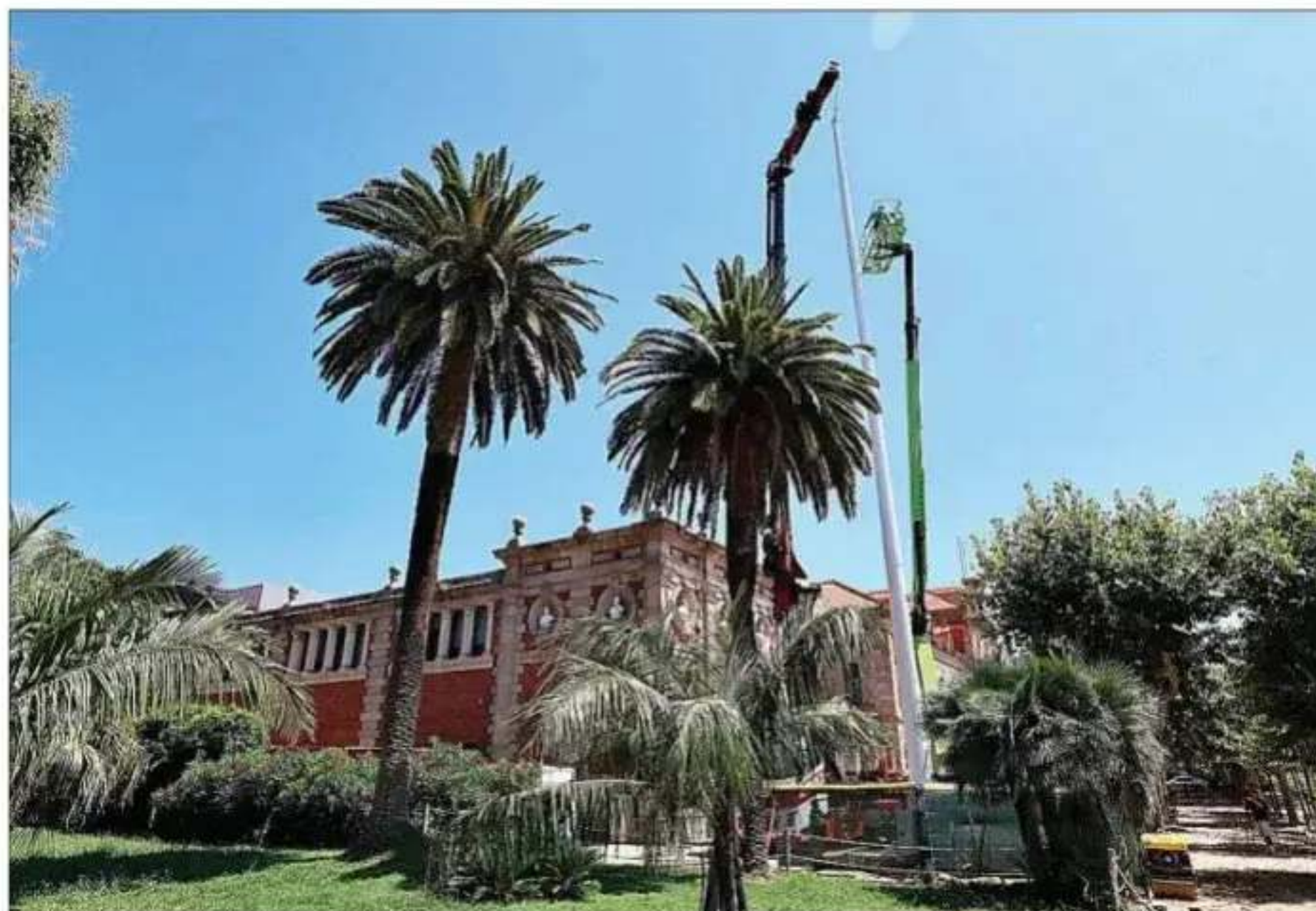
La instalación del mástil en los exteriores de la cámara catalana. PARLAMENT
